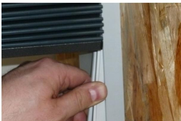
12. Insérez le profilé de guidage dans le guidage conformément à la photo 5 et à la Fig. 18.
