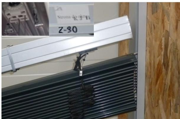
8. Desserrez le boulon du support élastique de rail, de sorte que la fermeture du support de rail puisse être ouverte librement.
