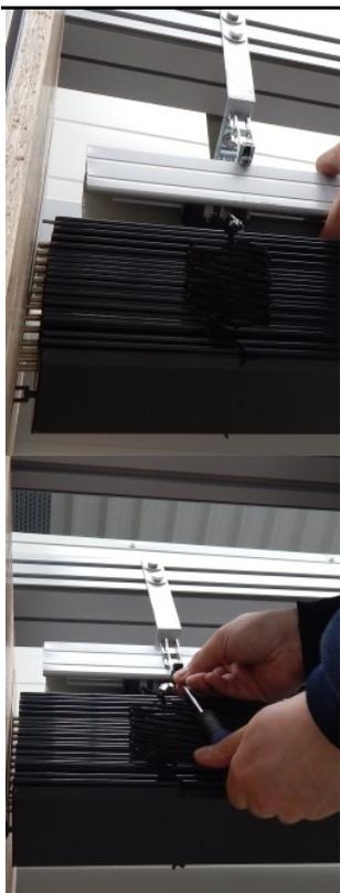
10. Soulevez le paquet de stores pour monter le rail principal du store sur les supports principaux. Faites particulièrement attention à ce que les goupilles de guidage soient correctement insérées dans le rail de guidage.
