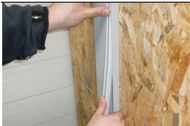
13. Montez le profilé de guidage sur toute la longueur du guidage, conformément à la photo 6 et à la Fig. 19.
